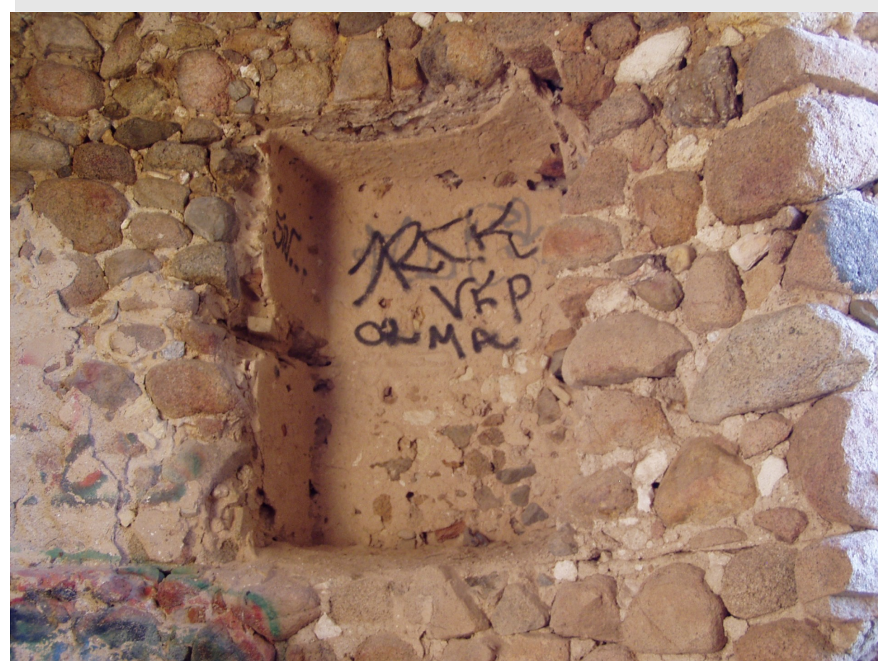
Nicchia intonacata a fianco del portello d'ingresso
